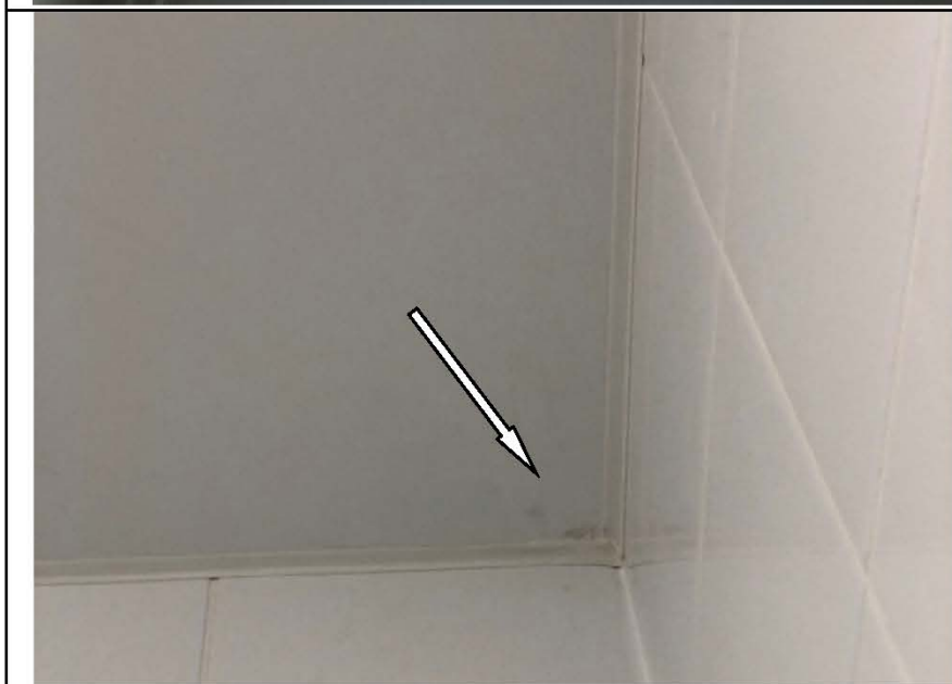
Фото №24. Дефект натяжного потолка в санузле (загрязнения).
