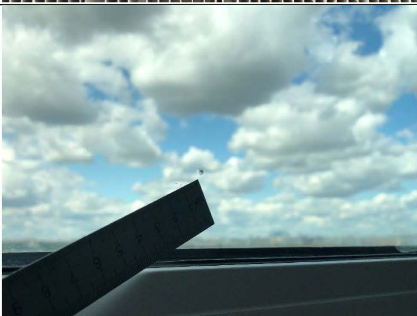
Фото №12. Скол на стеклопакете оконного блока ПВХ в комнате с кухней.
