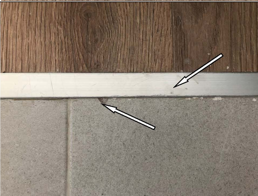
Фото №20. Отбитость напольной плитки в холле. Деформация напольного металлического порожка.
