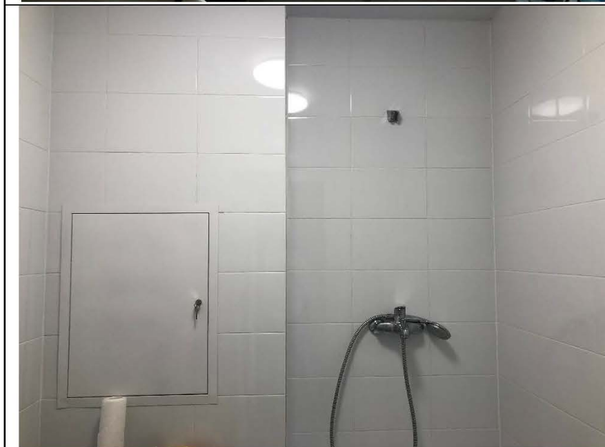
Фото №3. Общий вид санузла в квартире.
