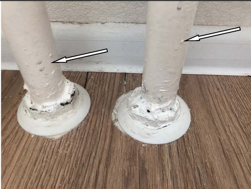
Фото №19. Дефект окрасивания труб отопления в комнате с кухней.
