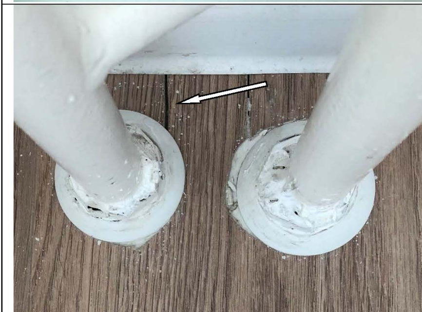
Фото №18. Дефект напольного покрытия в комнате с кухней.
