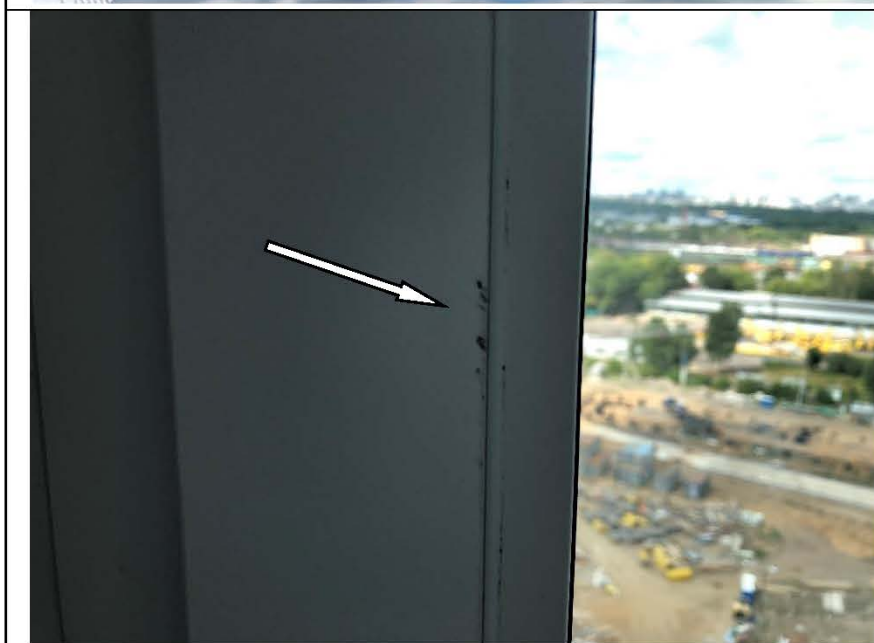
Фото №15. Дефект профиля оконного блока ПВХ в комнате с кухней.
