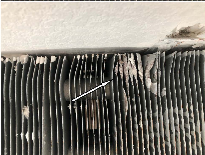
Фото №11. Дефект радиатора в комнате с кухней (загрязнения, замятия).
