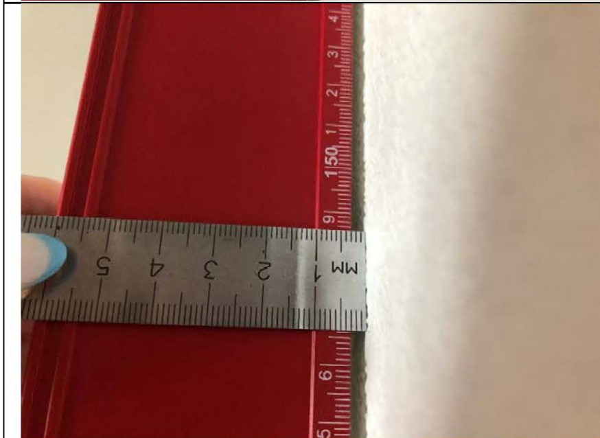
Фото №5. Измерение уровня стен коридора в квартире.
