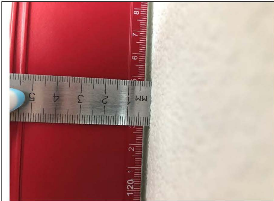
Фото №4. Измерение уровня стен комнаты с кухней в квартире.
