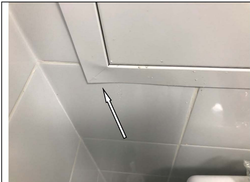
Фото №22. Деформация люка сантехнического в санузле.
