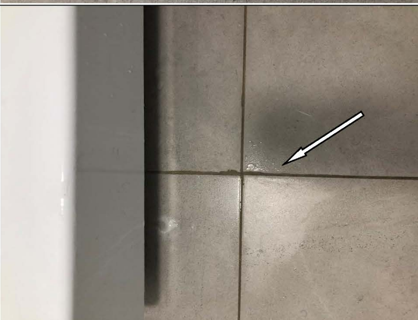
Фото №21. Дефект шва напольной керамической плитки в санузле.
